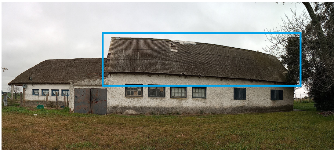
Sector Existente, sustitución de Quincho + sobretecho de fibrocemento por Cubierta con Paneles Compuestos.
